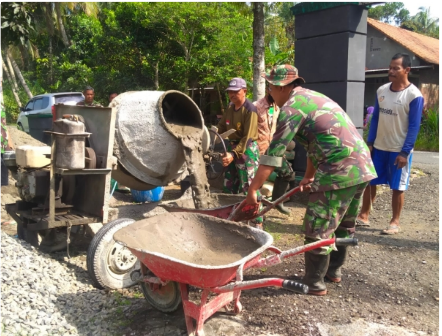
Anggota Posramil Bonorowo Bantu Warga Pengecoran Jalan
